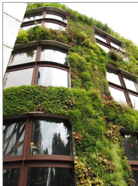
4 pav. Du Quai Branly muziejaus eksterjerai, suprojektuoti ir apželdinti Patrick Blanc ir Gilles Clément
